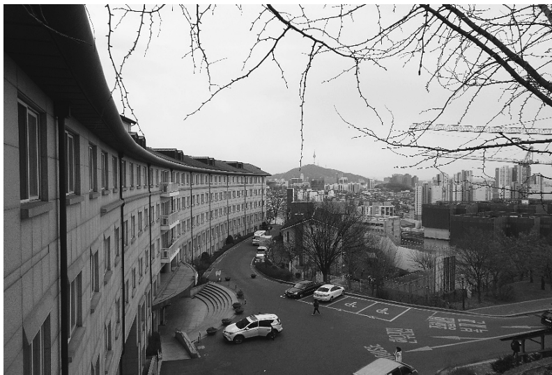
学生寮（House）の一部と、建設中の学生寮の一部 2018年時点で4,300名がキャンパス内で暮らす。1年生全員が暮らせるようにする計画があるようだ。（2019年3月13日撮影）
